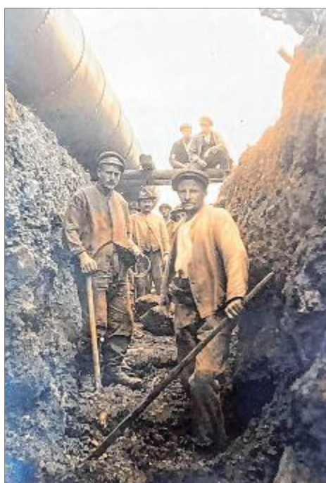
Zum Produktprogramm von Gräbener zählten in den Anfangsjahren auch Rohrleitungen. Foto: Unternehmen
